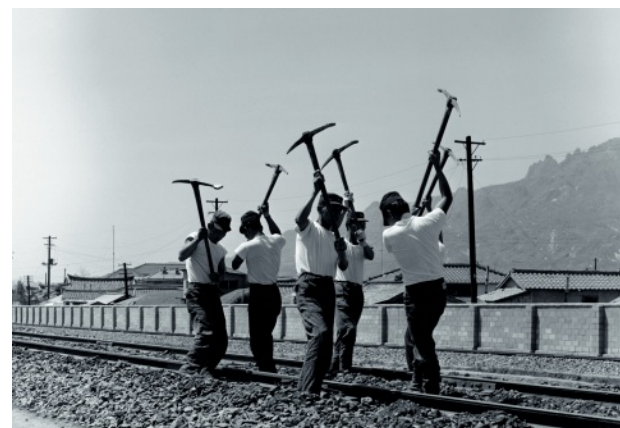
©류후선 사진09 1967년 의정부 가동동 철길 보수공사를 하는 노동자들의 모습. 철길 위 노동자들의 곡괭이질 소리와 노동요의 리듬은 멋진 앙상블을 연상케 한다. 그 뒤로 도봉산이 보인다.
